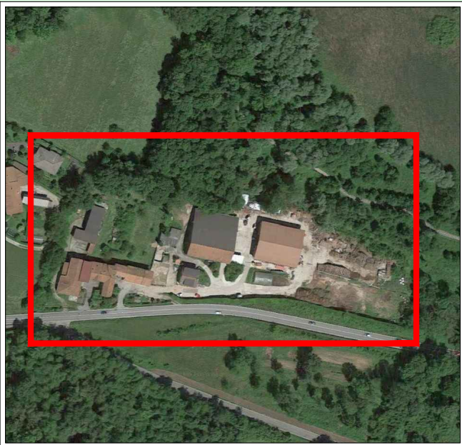
Fig. 1: Comune di Galliate Lombardo - Vista aerea zona d'intervento
