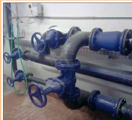
Fig. 4: Migliorie delle procedure di manutenzione e gestione - Formazione by-pass esterno
